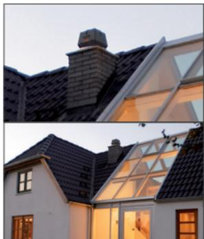
Der Abgasventilator wird auf den Schornsteinkopf montiert und ist sowohl für den gemauerten oder den Edelstahlschornstein verwendbar.
